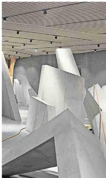
Blick in den Rohbau der Erlebnishalle. Im Vordergrund die «Bergsturz-Splitter».
